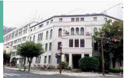
病院移転後も歴史ある一号館は3階まで残りますが、4階の外科研究室は取り壊されます。
